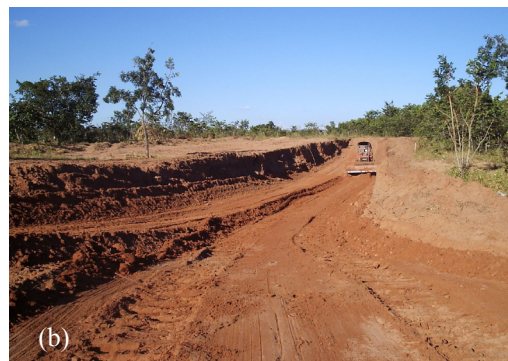
FIGURA 3: (a) Área escolhida para construção da trincheira; (b) Construção da vala.
