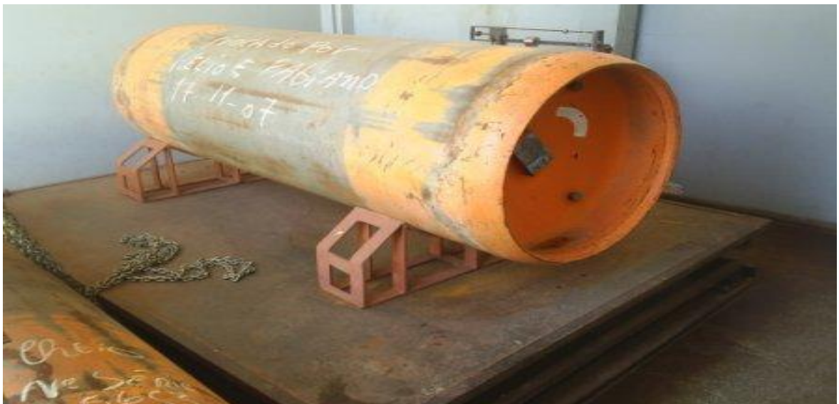
Figura 7. Etapas de Tratamento ETA II – Desinfetante –Gás Cloro.
