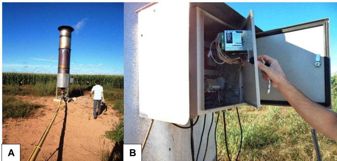
Figura 5: (A) - queimador utilizado para combustão do gás metano produzido no biodigestor. (B) - Aparelho que armazena os dados da quantidade de gás queimado.
