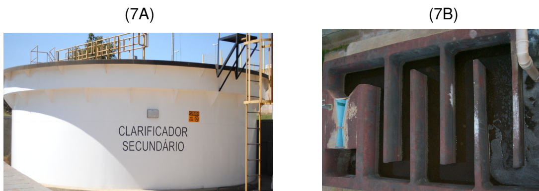
Figura 7. Clarificador secundário (A) e sistema de desinfecção (B) ( Fonte: RAMOS, 2011)
