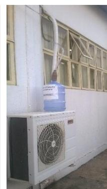
(1d) Forma de coleta da água de drenagem do ar condicionado.
