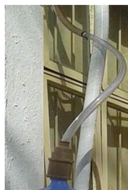
(1c) Conexão do dreno do ar condicionado ao recipiente coletor.
