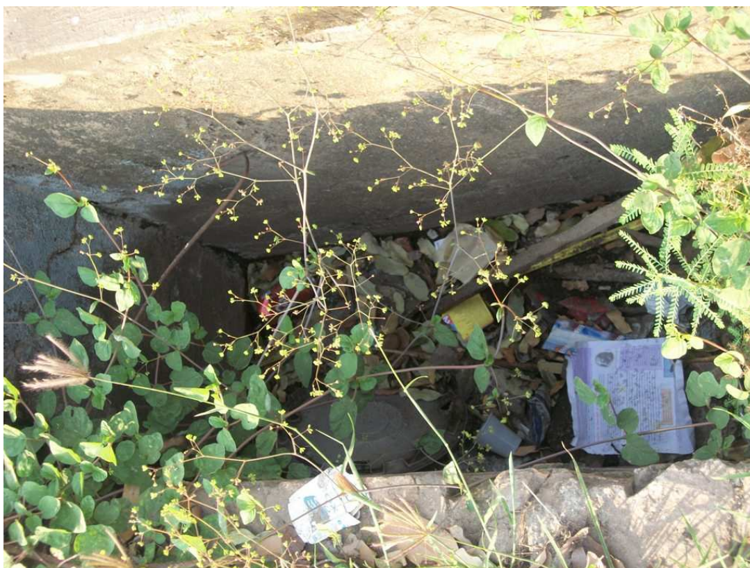
IMAGEM 4 – Lixo entupindo as galerias de esgoto no bairro Grande Terceiro. Fonte: Joab Almeida da Silva
