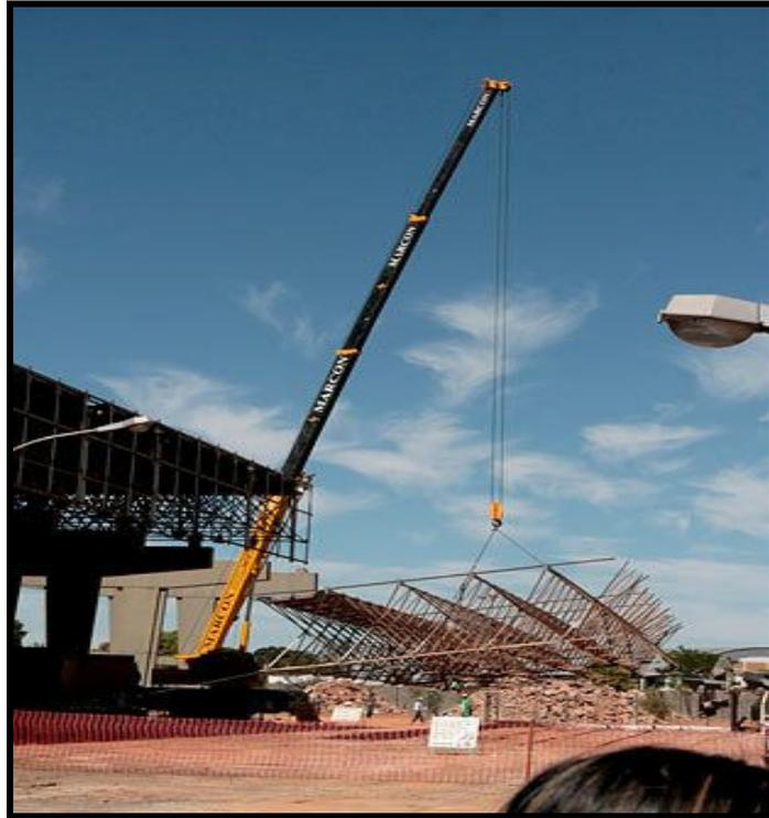
Figura 3 - Remoção da estrutura metálica da cobertura do estádio.
