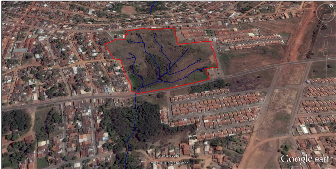
Figura 06: Visualização e delimitação do perímetro da nascente do Córrego Vassoral (polígono em vermelho) e seu entorno urbanizado, com condomínios horizontais (direita) e ocupações irregulares (esquerda).
