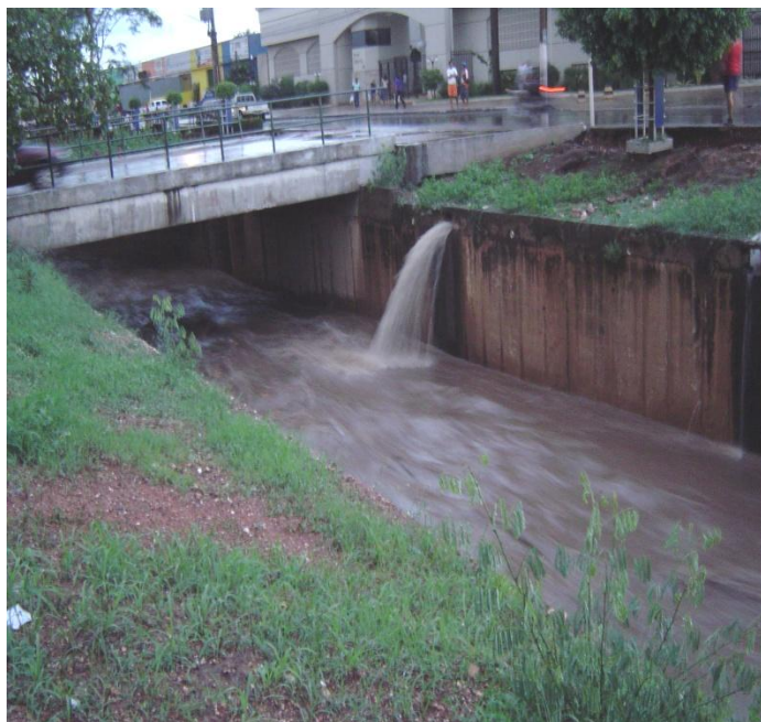
Figura 8. Drenagem do escoamento urbano no Córrego Barbado, Cuiabá-MT em período de chuvas. Fonte: Silva (2009)
