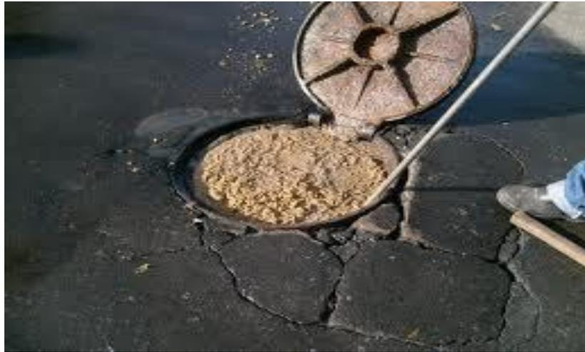
Figura 01: Bueiro de esgoto entupido por gordura solidificada (Fonte: CESAN- GUARAPARI, 2010)
