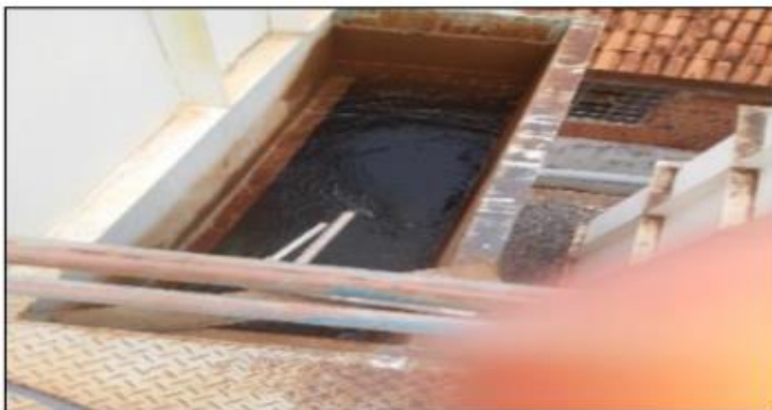
Figura 5. Decantador de alta taxa, coberto, da ETA metálica
