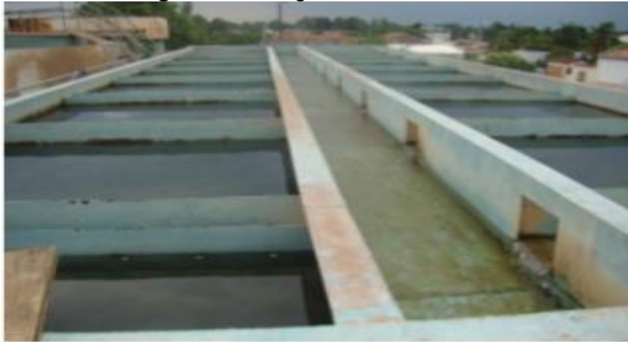
Figura 3. Vista geral do decantador
