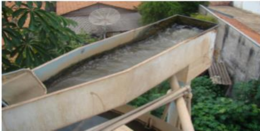
Figura 1. Calha Parshall
