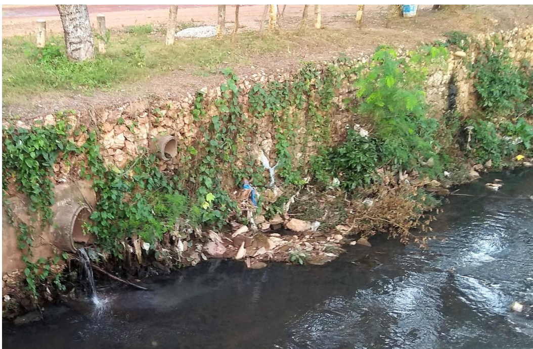
Figura 9 - Lançamento de esgoto no córrego Três Barras por meio de ligação clandestina no ponto 5 (Fonte: próprio autor, 2018)
