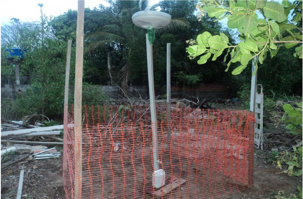
Figura 8 – Modelo de sistema de captação de águas pluviais completo/Vista 2 - Implantação: Parque Geórgia (Foto: Alexandre de S. C. Teixeira).
