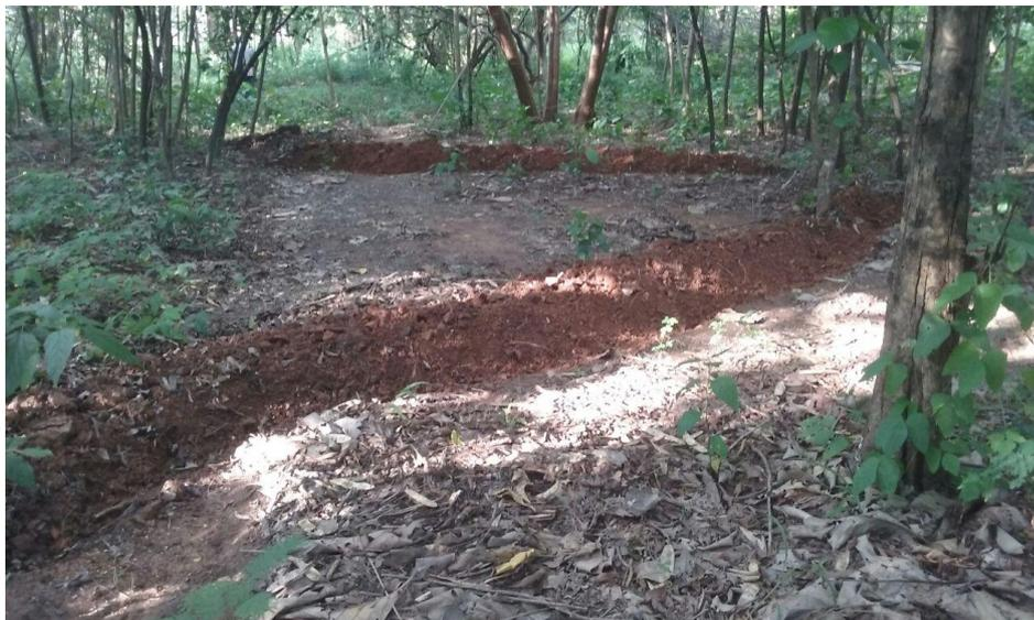
Figura 04: Curvas de níveis, para deslocamento de água no IFMT Campus Cuiabá Bela Vista (FONTE: Autor próprio, 2016).
