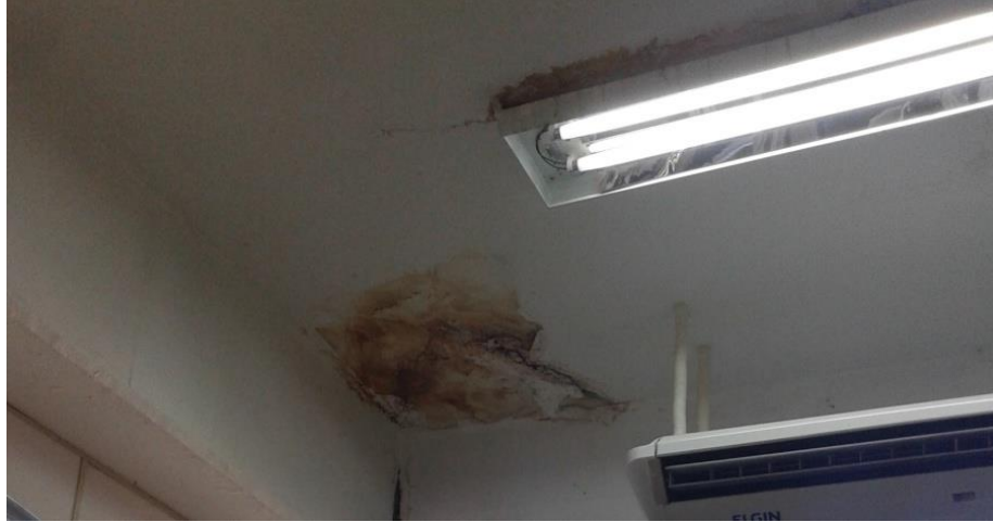
Figura 3. Teto danificado
