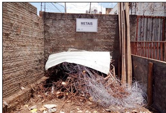
Figura 8 – Baia de armazenamento de metais
