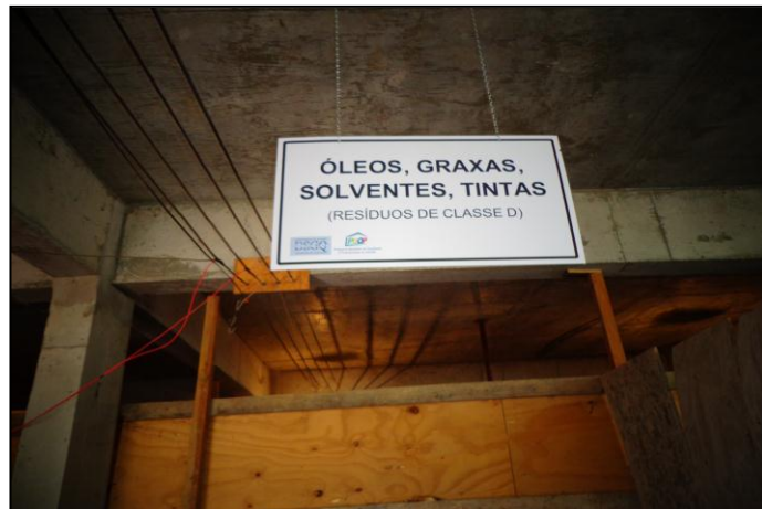
Figura 9 – Baia de armazenamento de resíduos classe D
