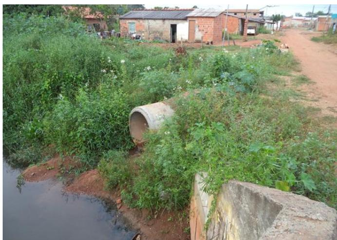
**Figura 15** - Exposição das manilhas de captação de esgoto com lançamento direto no córrego Jacaré sentido Engordador no bairro Jardim Ipanema em Várzea Grande/MT.
