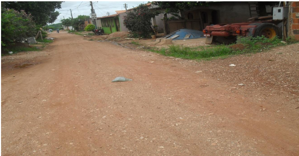
Figura 2: Presença de esgoto a céu aberto em frente às casas. Fonte: Ojeda, 2013.
