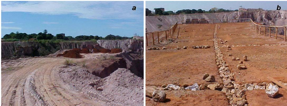
**FIGURA 4.** Setor A – a) terraplanagem do mirante; b) implantação dos drenos com pedra de mão.
