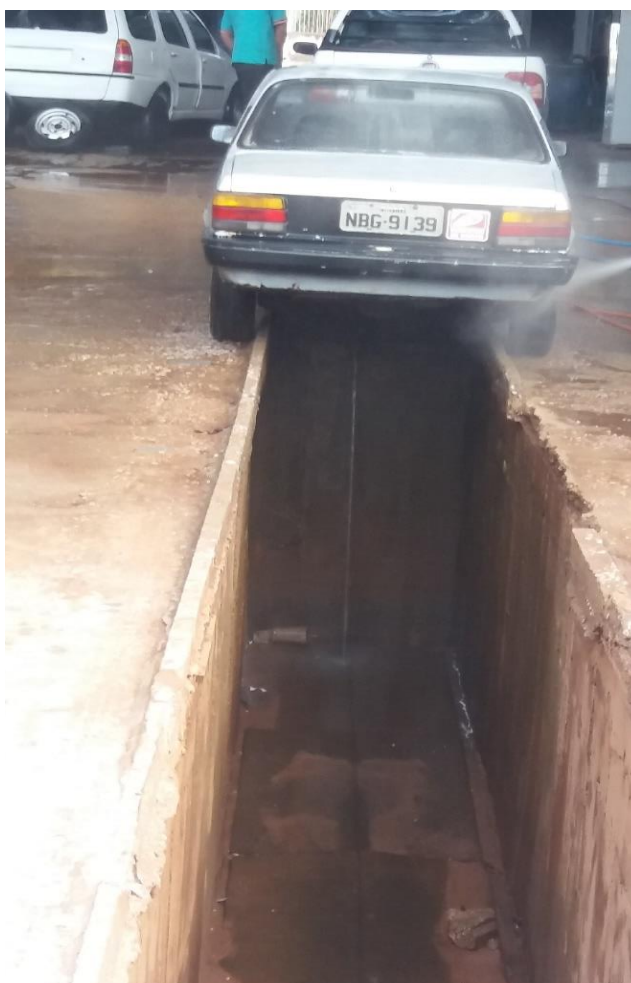
Figura 6 - Caixa Separadora água e óleo e Floculação (Fonte: Autor próprio;2017).
