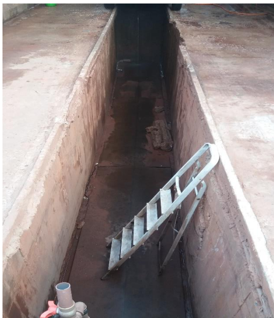
Figura 7 - Caixa de Armazenamento (Fonte: Autor próprio;2017)
