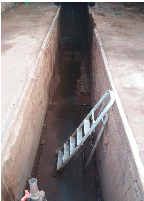
Figura 16 – Visão interna da Rampa (Fonte: Autor próprio;2017)
