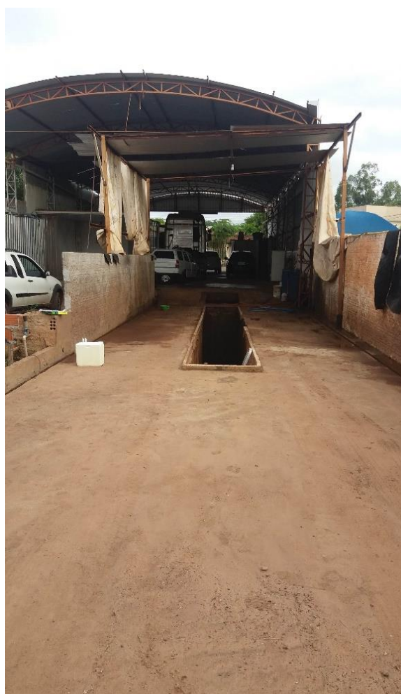
Figura 26 – Visão geral da Rampa (Fonte: Autor próprio;2017)
