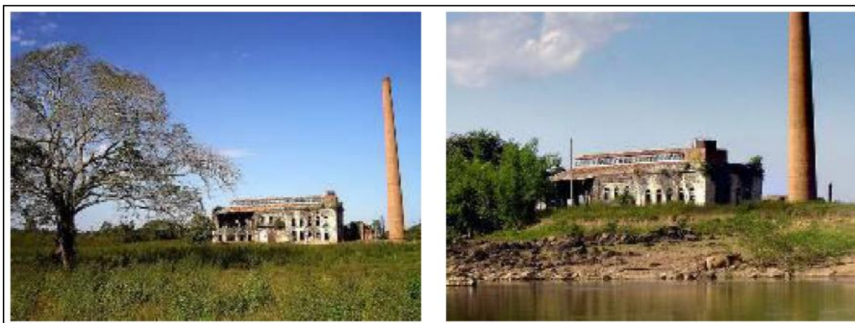
Figura 06: Vista das ruínas da Usina Itaicy, na margem direita do rio Cuiabá (Fonte: LIMA, 2010).
